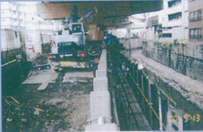
使用機械：10t ラフター 東京都目黒区（首都高速目黒線高架下）杭 H300 L=10.0m ミルク注入 H 鋼打設 桁下 GL+6.5m
