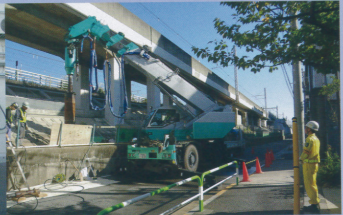
使用機械：10t ラフター 東京都目黒区（首都高速目黒線高架下）杭 H300 L=10.0m ミルク注入 H 鋼打設 桁下 GL+6.5m
